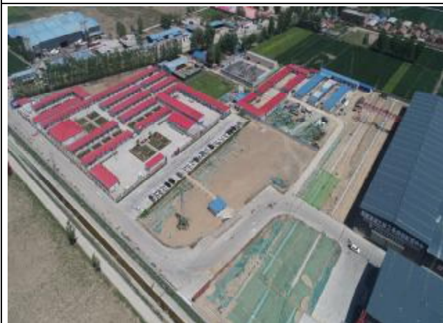
三标施工生活区
