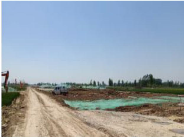
k25+700 施工道路（上季度）
