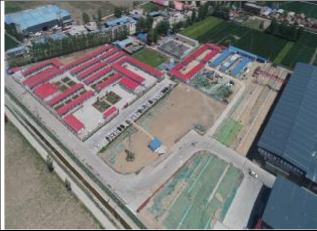
三标施工生产生活区（上季度）
