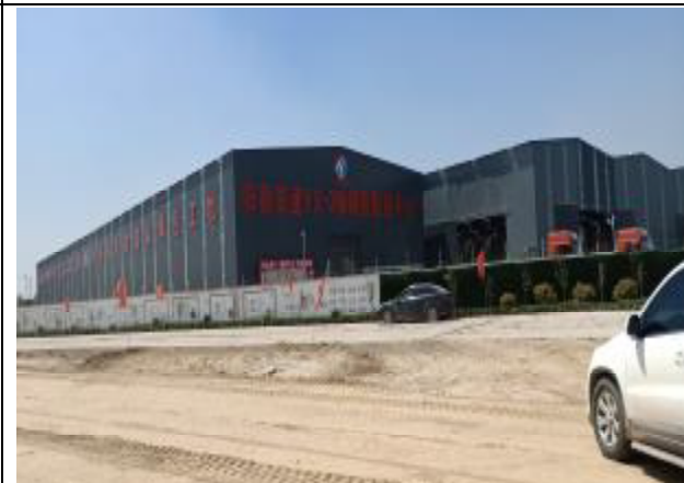
二标施工生产区
