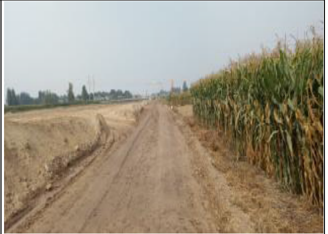
k25+700 施工道路（本季度）
