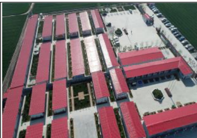
一标施工生产区
