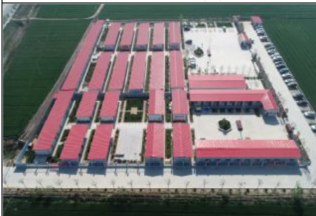
二标施工生产生活区 (上季度)
