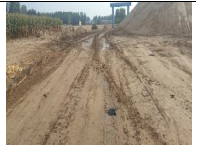
K7+000 施工道路（本季度）
