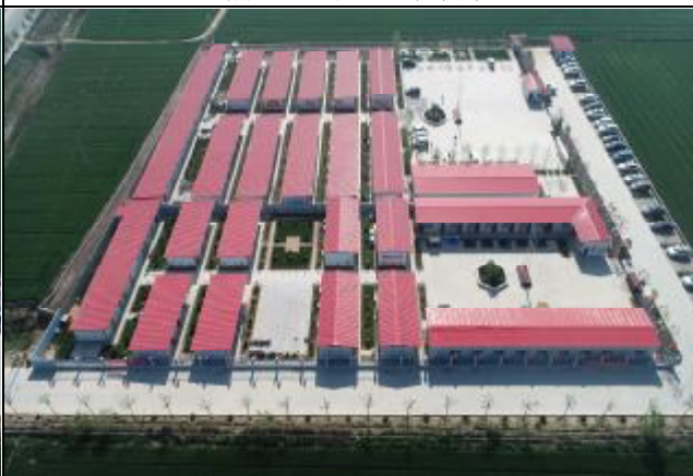
二标施工生产生活区 (本季度)
