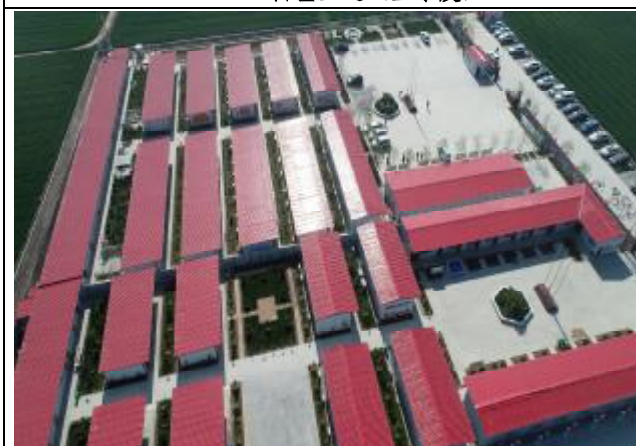
一标施工生活区 (上季度)
