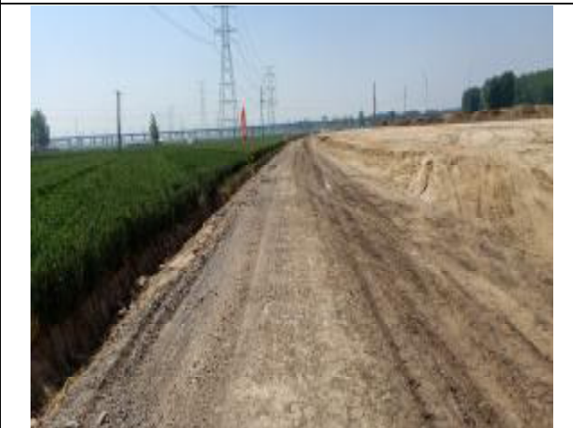
K7+000 施工道路（上季度）
